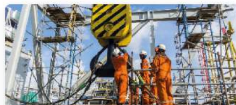
Ремонт и монтаж ЛЭП
