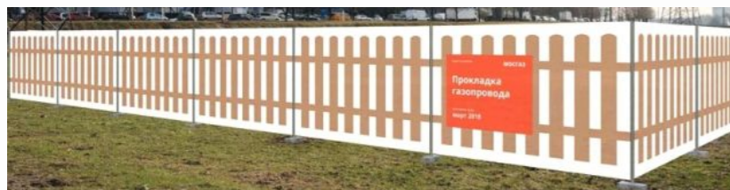
Временные ограждения строительной площадки «ШТАКЕТНИК»
