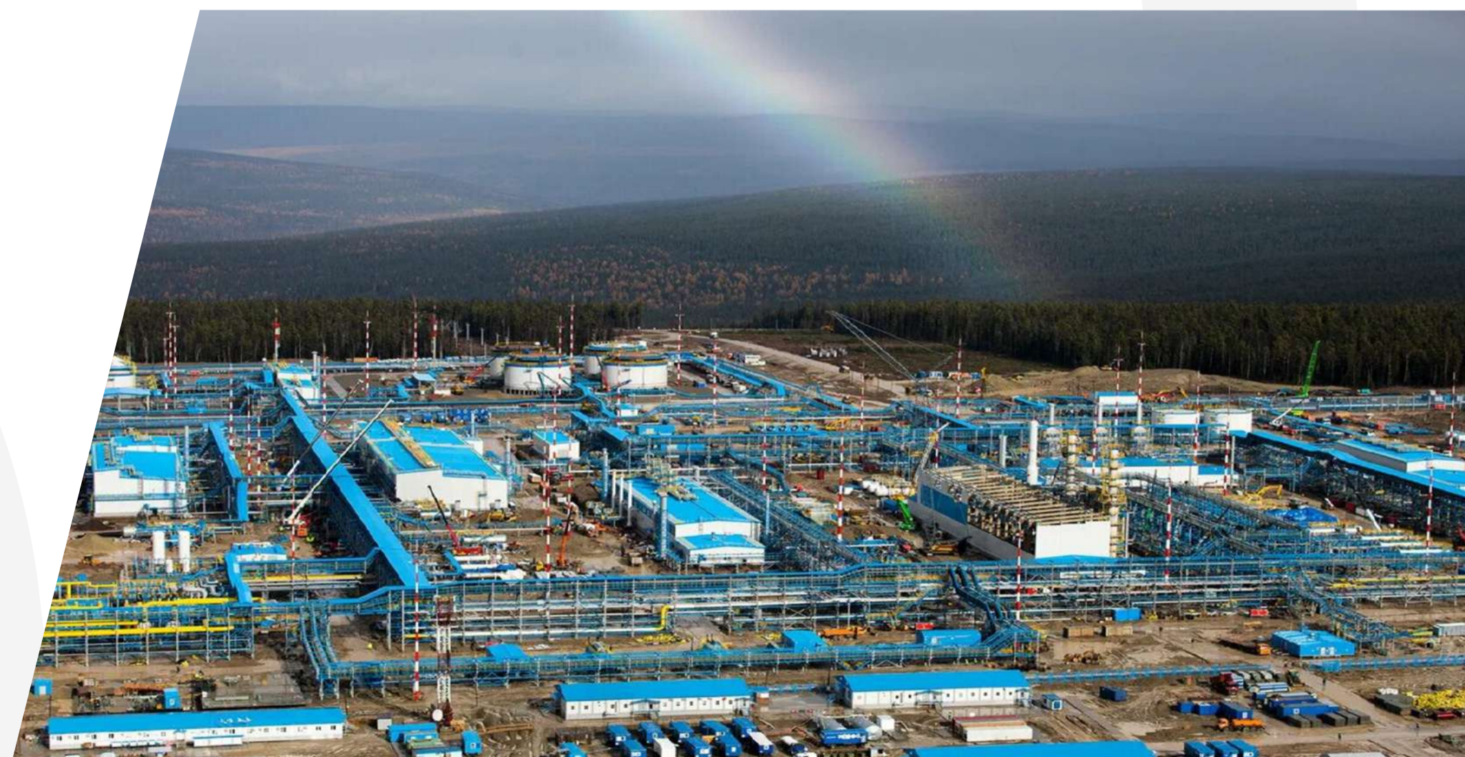
Техника "ARZGROUP" на Ковыктинском ГМ, а также на Чаядинском НГКМ
